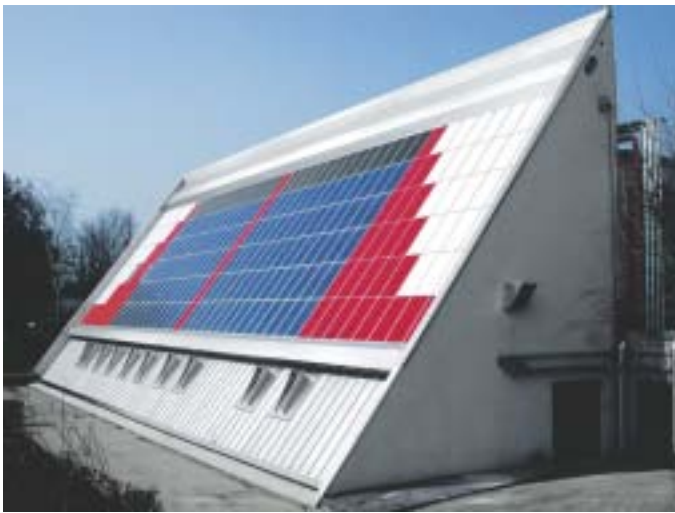
Abbildung 3 Diese belüfteten PV-Kollektoren mit Wärme- gewinnung – TIS von Secco Sistemi – sind am Centro Ri- cerche Fiat di Turin in Italien installiert
